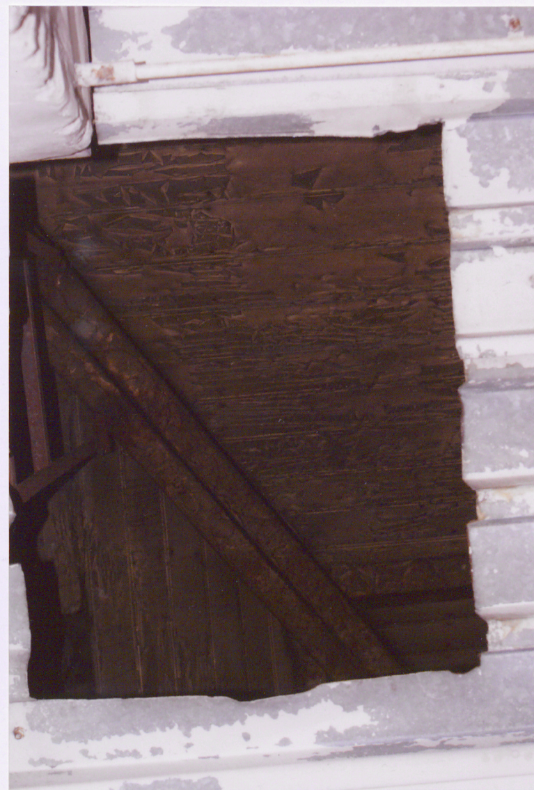
Fot. 13 Narożnik południowo-zachodni pomieszczenia piętra – widoczna konstrukcja dachu.
