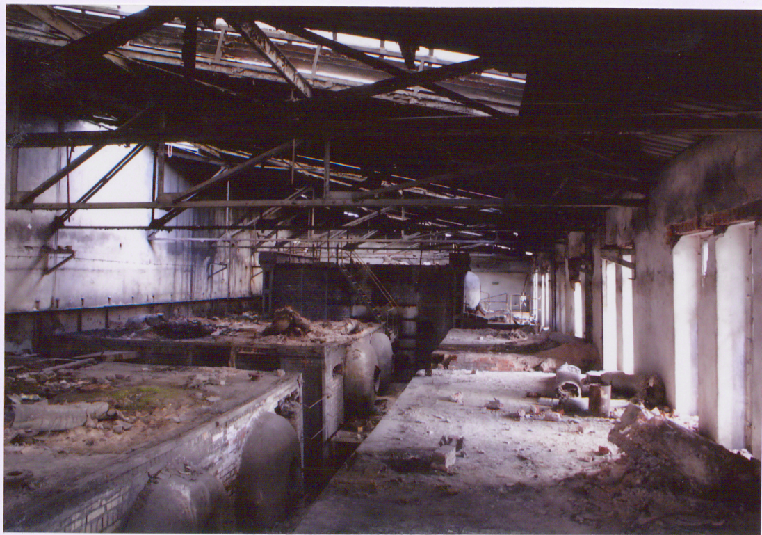
Fot. 14 Wnętrze kotłowni – konstrukcja dachu ze świetlikami, część południowa pieców Fitznera, w głębi wyższy Humboldta.
