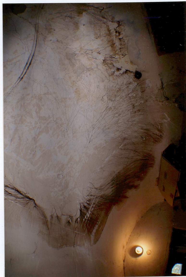
Fot. 9 Parter – sklepienia przedsionka przed zejściem do piwnicy – okaz grzyba domowego.
