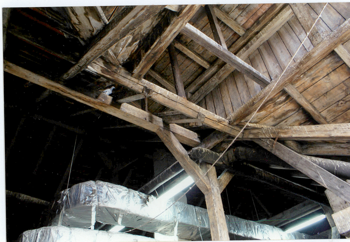
Fot. 22 Wieżba dachowa eklektycznej części szpitala.
