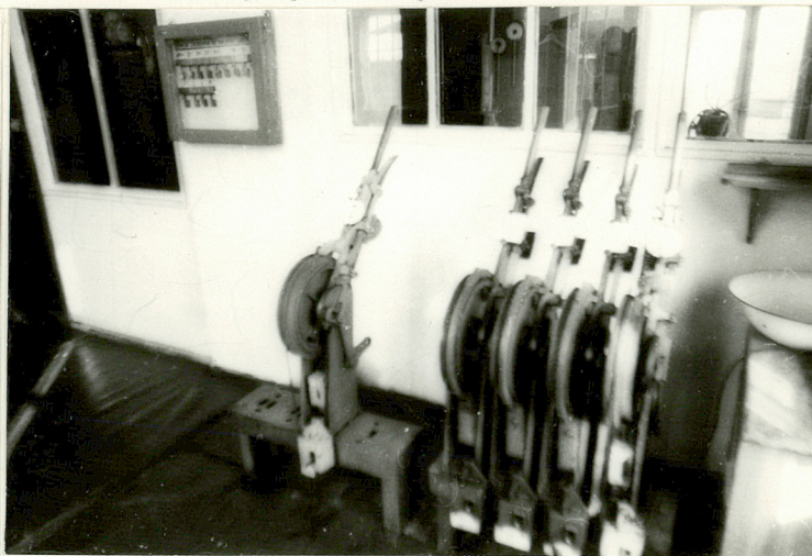
Urządzenia nastawcze /dyżurka/
