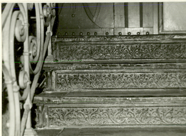
Metalowa konstrukcja schodów frontowych oraz metalowa ozdobna balustrada z drewnianą poręczą.
