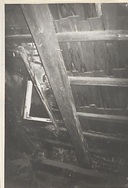
Poddasze -ściana ogniowa (półn.), fragment więźby dachowej , pokrycie gontowe
