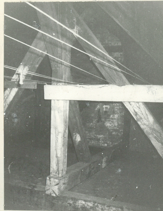
System konstrukcyjny więźby dachowej
