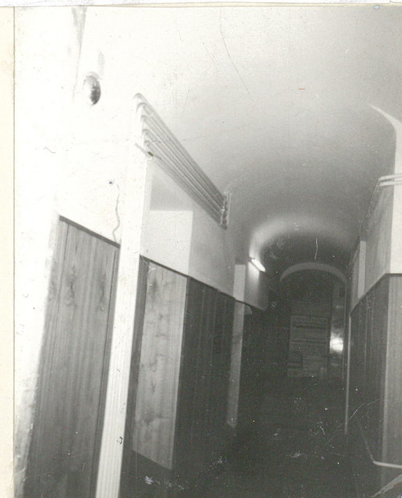
parter, korytarz do przybudówki - sklepienie kolebkowe
