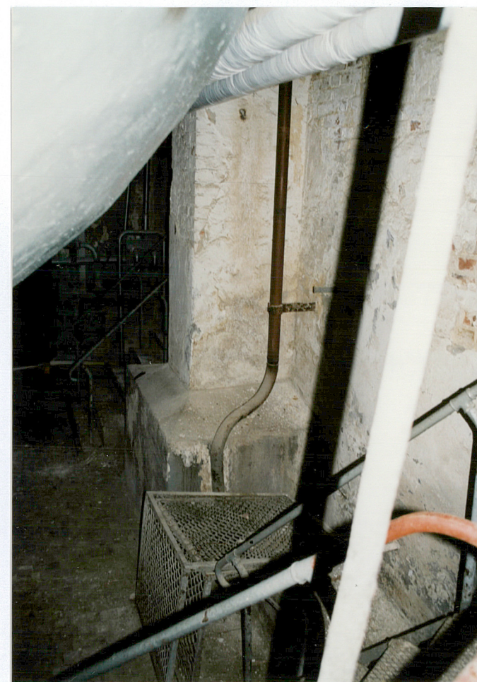
6. Odslonięty fragment ławy fundamentowej
