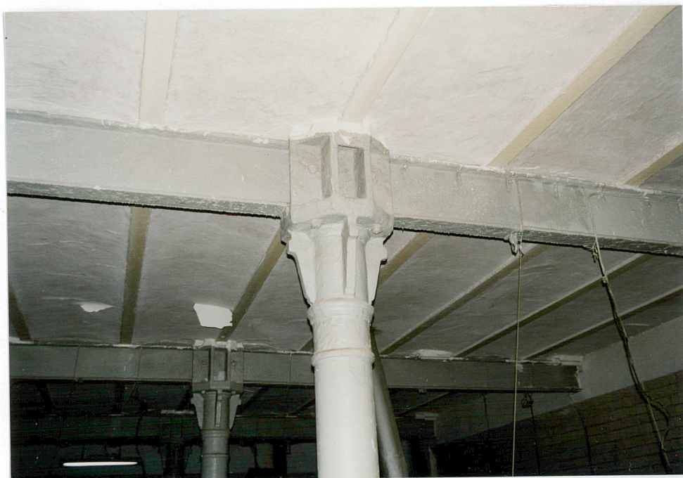
7. Warzelnia - strop i podciąg z podporą
