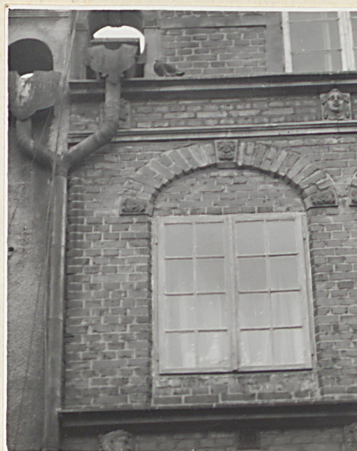
9. Elew. pn - odpływ wody deszczowej
