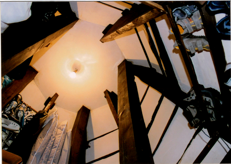
Konstrukcja hełmu wieżyczkowego ryzalitu północno-zachodniego w mieszkaniu na poddaszu w części zachodniej w trakcie północnym.
