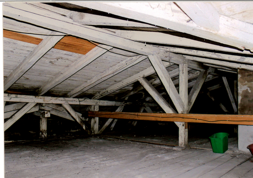
Strych- górna część konstrukcji więźby dachowej.
