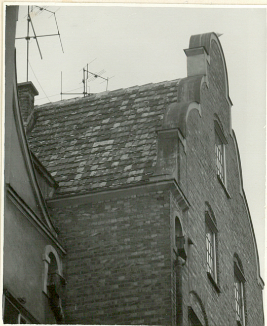
11. Pokrycie dachu - dachówka bitumiczna (holend.)
