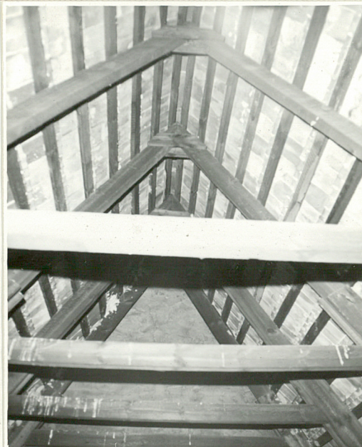
17. Konstrukcja więzby dachowej
