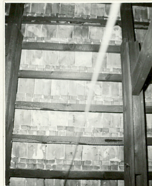
18. Konstr. więzby dach. - fragm. między przęsłami
