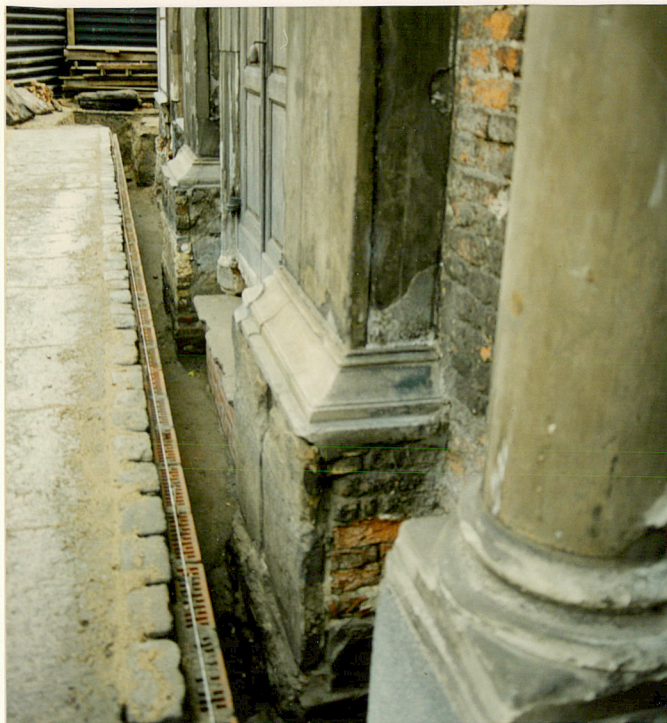
7. Odsłonięte fundamenty fasady.
