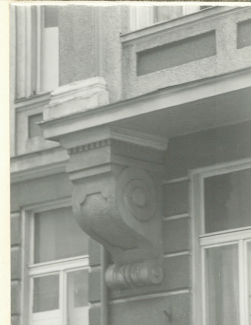
18. KONSOLA PODPIERAJĄCA BALKON I ELEWACJA FRONTOWA PN.-WSCH.
