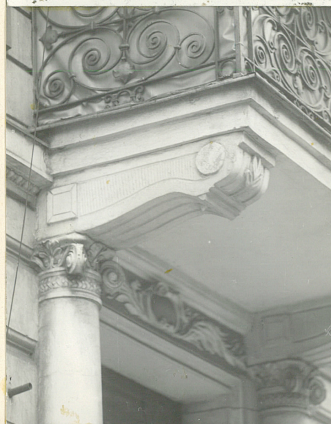
5. ELEW. FRONT. - FRAGMENT WYSTROJU - KONSOLA PODP. BALKON
