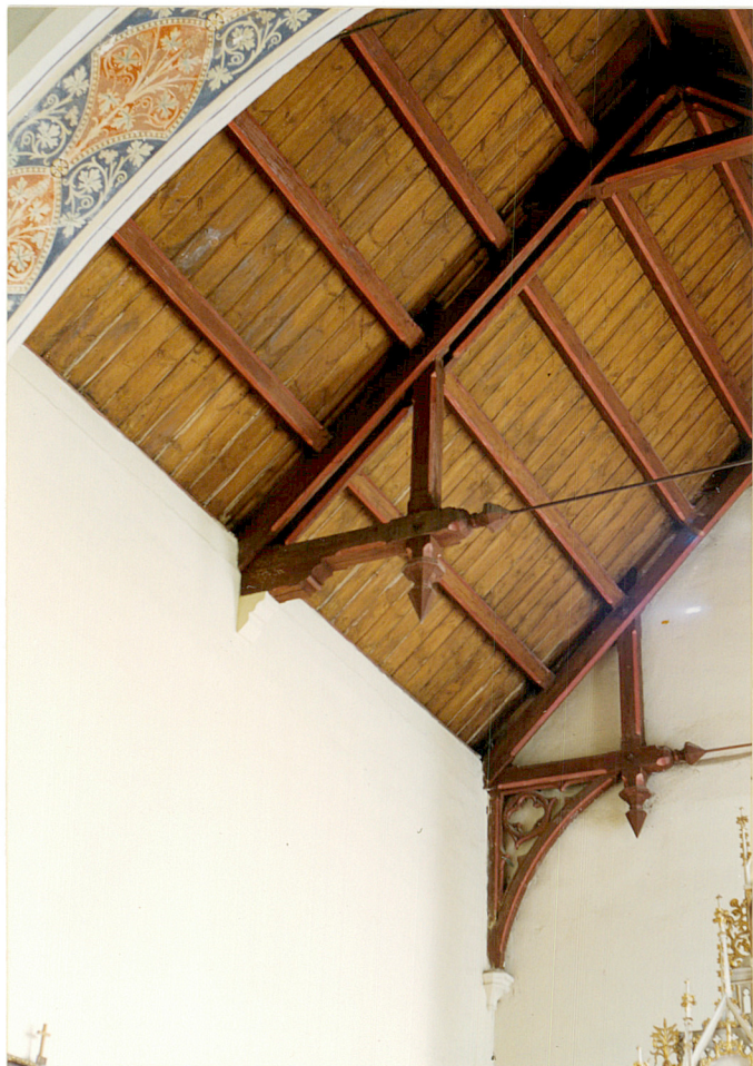
22. Fragment dolnej części więźby dachowej nad prezbiterium.
