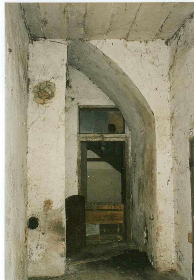
13. Korytarz, widok w kierunku sieni; po bokach widoczne dwa przewody kominowe, schodzące się na poddaszu w tzw. szeroki komin
