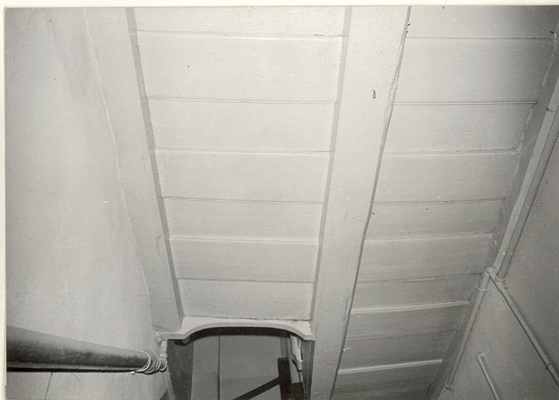
Obudowane drewniane belki stropowe nad piętrem
