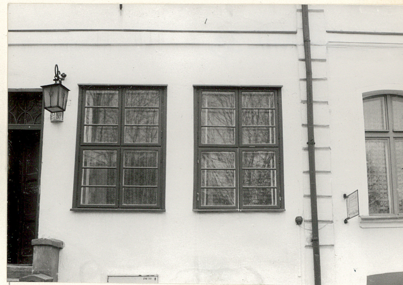
Elewacja frontowa-rekonstruowane okna 12-to kwaterowe
