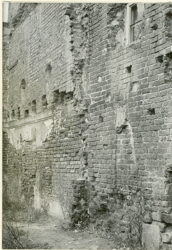
Sciana obwodowa /północna/ ślad po ścianie dzielącej na trakty
