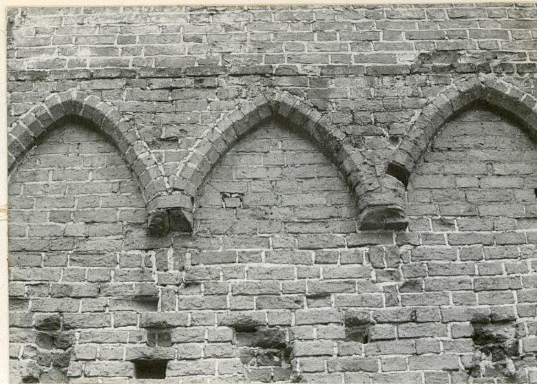
Fryz arkadkowy /ściana północna/.Widoczne gniazda belek stropowych
