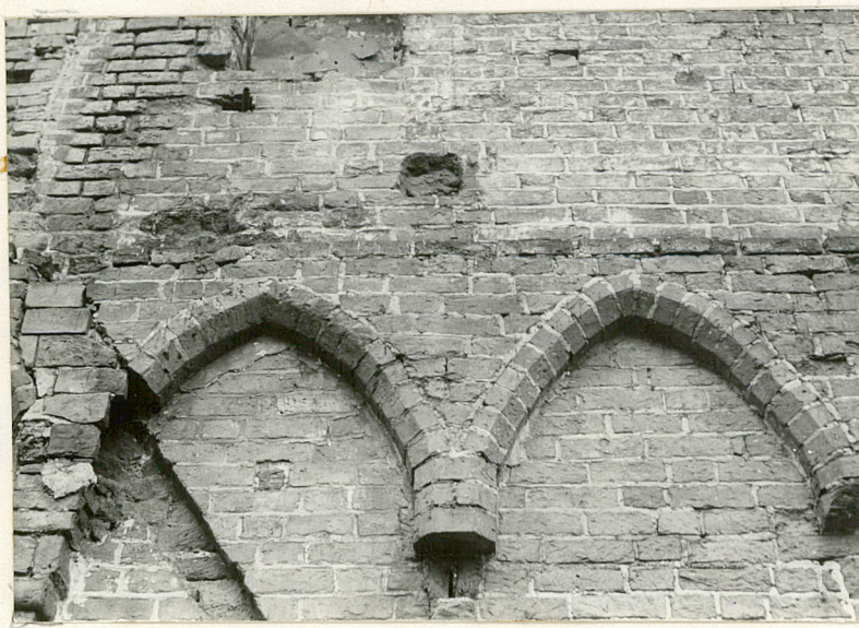
Sciana północna, ślad po biegu schodowym na piętro
