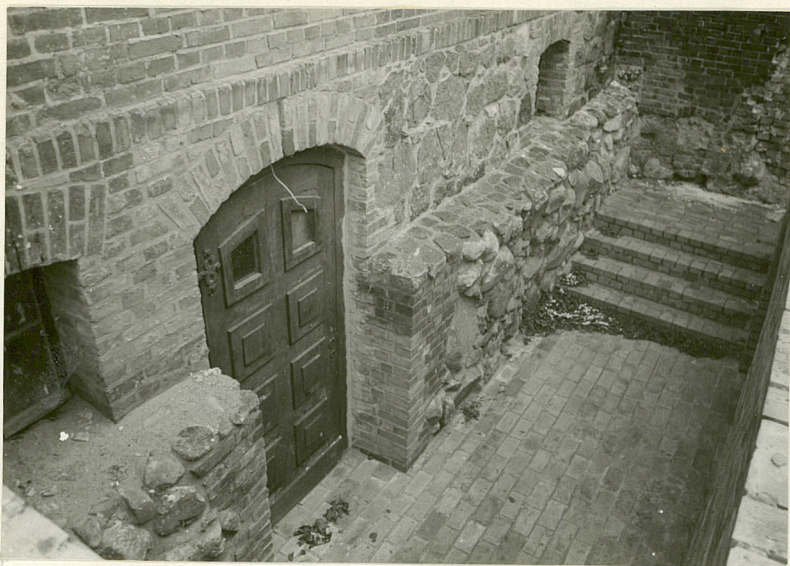
Sciany fundamentowe w szczycie zachodnim
