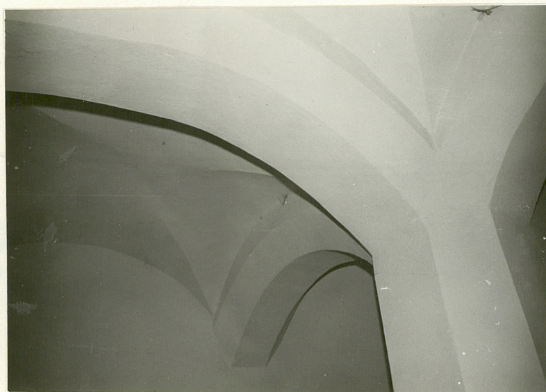
Sklepienie klatki schodowej
