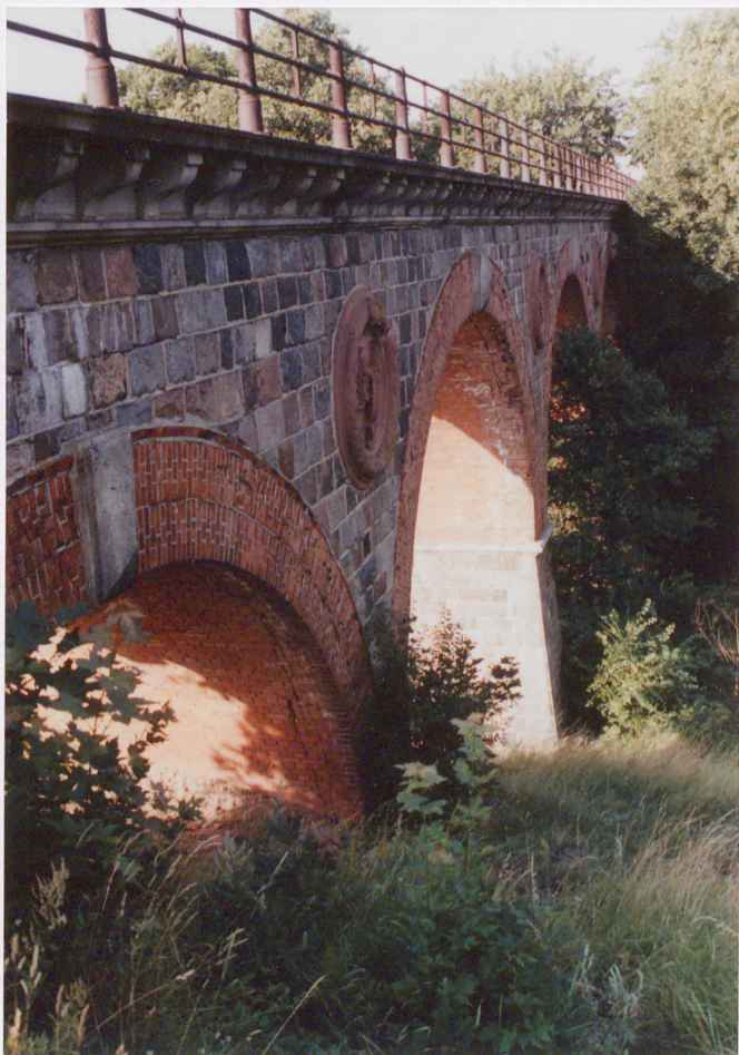
4. Tarcza czołowa i gzyms od strony górnej wody, neg. 400/886/1
