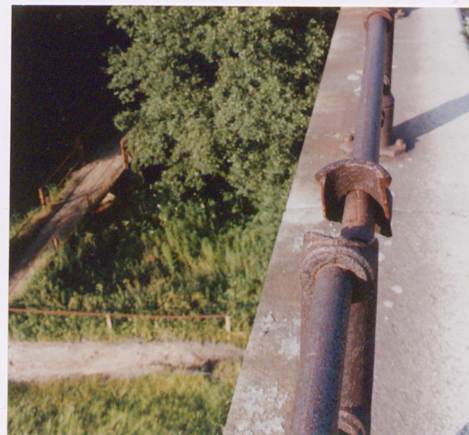
19. Uszkodzenia żeliwnej bariery, neg. 400/875/5
