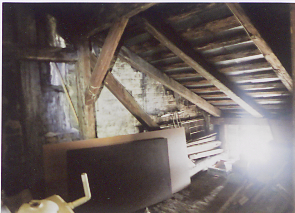
Fragment więźby dachowej w cz. pd.-wsch.
