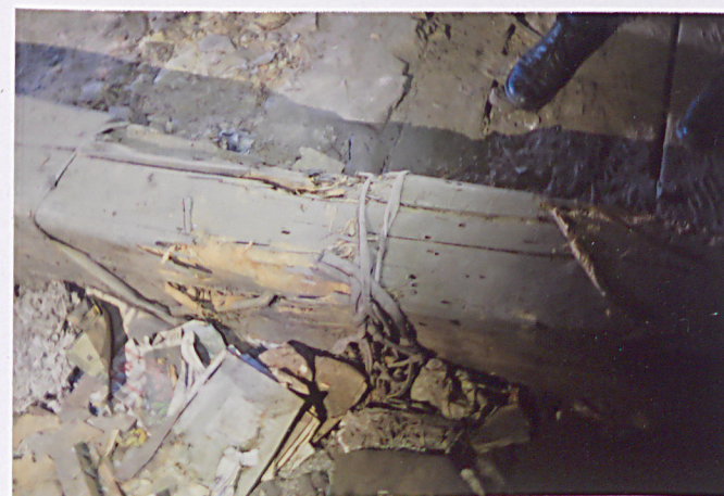
Frag. więźby od pd.-zach. oraz jeden z uszkodzonych tramów
