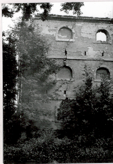
Zachodni fragment ele- wacji pld. z wyraźnymi śladowi spękań na całej wysokości muru
