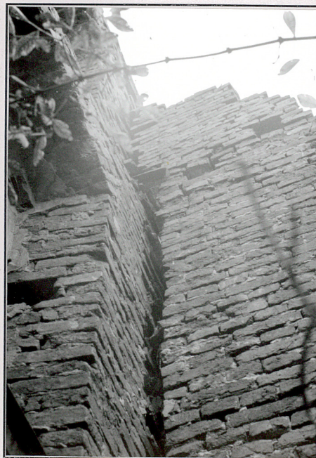
Fragment wewnętrznej przypory ściany płn. z wyraźnym odspoinowaniem łączenia z murem magistralnym
