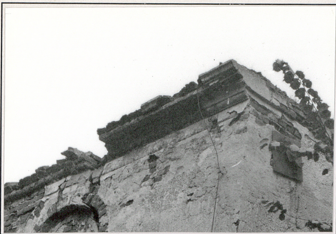
Fragment narożnika płd.-wsch. Pozostałości gzymsu wieńczącego
