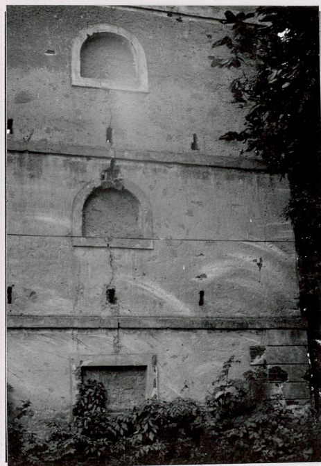
Wschodni fragment ele- wacji pld. ze śladami spękań muru
