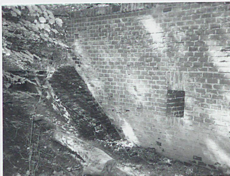
Skarpa fundamentu krótszego ramienia wchodząca w wał
