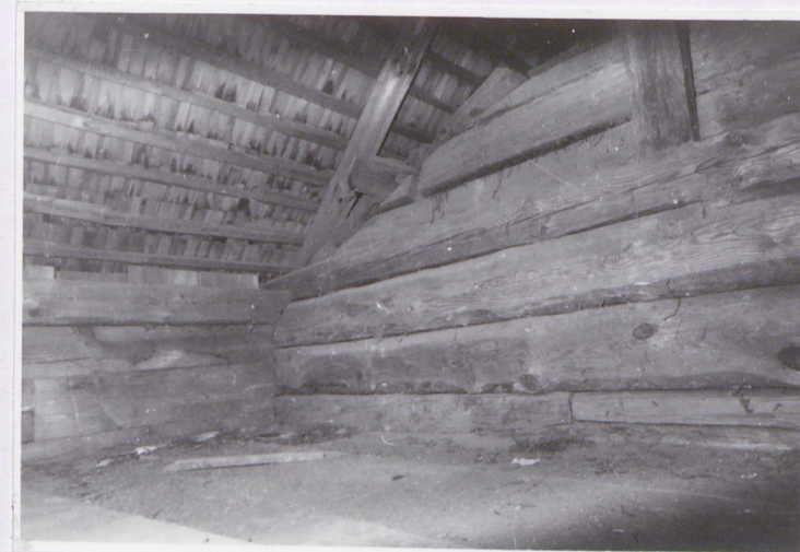
konstrukcja sklepienia sanktuarium wsch.cz.
