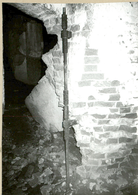
Stalowy pręt do mocowania zawiasów drzwi w przejściu z poterny do schronu głównego
