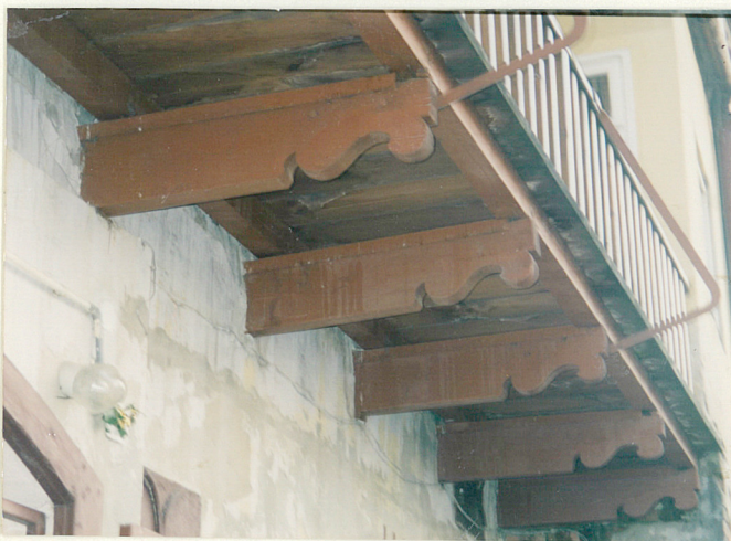
Wsporniki balkonu w elewacji tylnej
