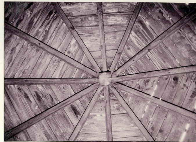
Konstrukcja dachu altany
