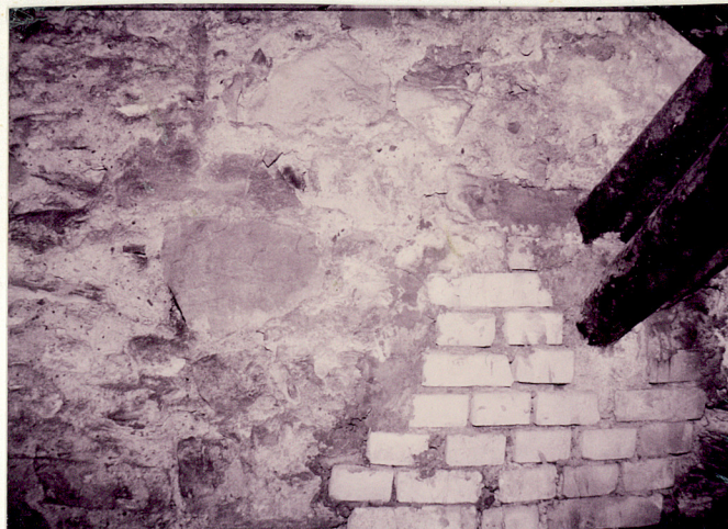
Konstrukcja ścian piwnicy z współczesnym uzupełnieniem
