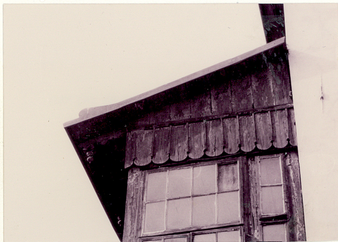
Górna część werandy - szczyt - z ozdobnie wyciętymi resztkami krokwi i deskami szalunku
