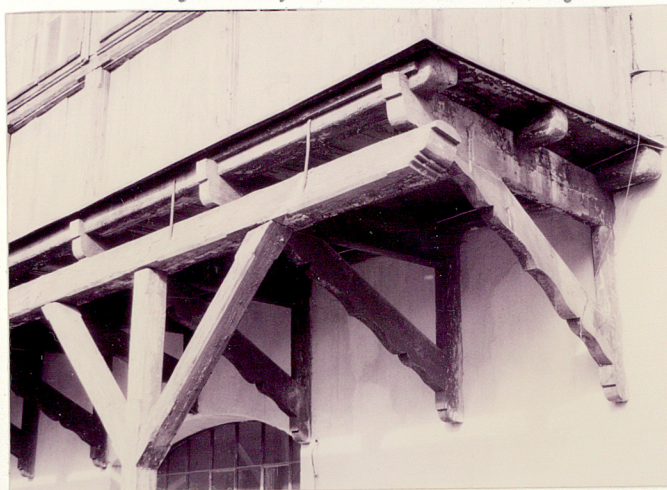
Konstrukcja podtrzymująca werandę
