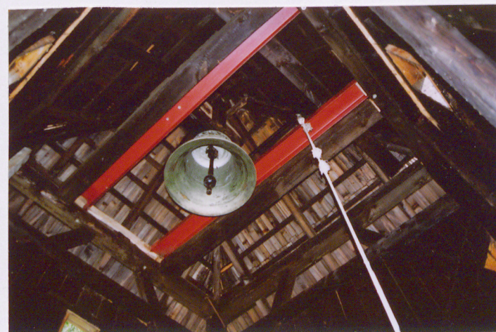
Hezba dachowa i zawieszenie dzwonu
