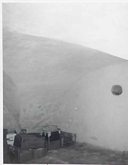
sklepienie kolebkowe z lunetami w piwnicy Nr.3
