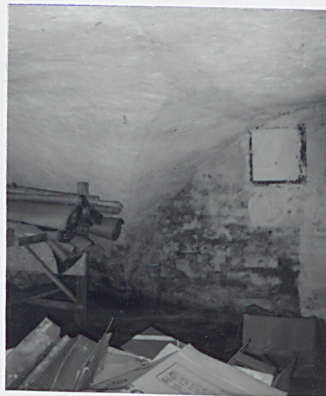
sklepienie kolebkowe z lunetami w piwnicy Nr.2
