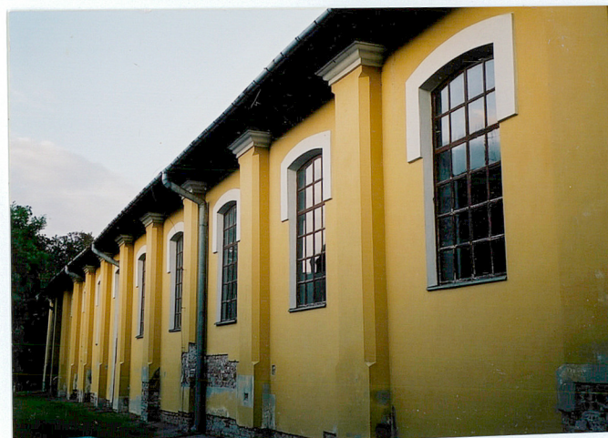
Elevacja boczna i tylna z fragmentami zniszczonych tynków
