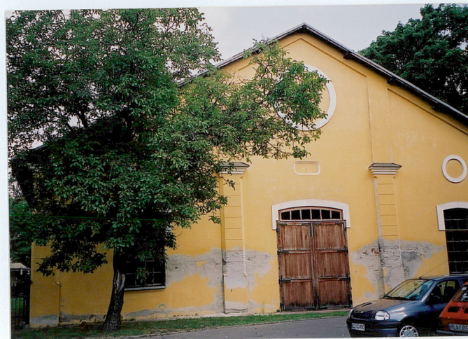
Elevacja boczna i tylna z fragmentami zniszczonych tynków
