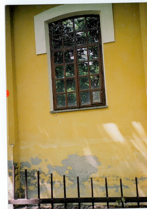
Elevacja boczna i tylna z fragmentami zniszczonych tynków
