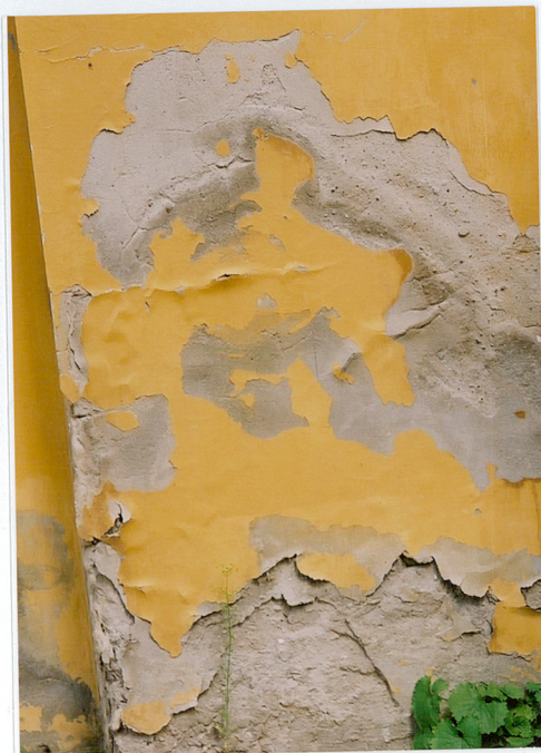
Fragment zniszczonego tynku
