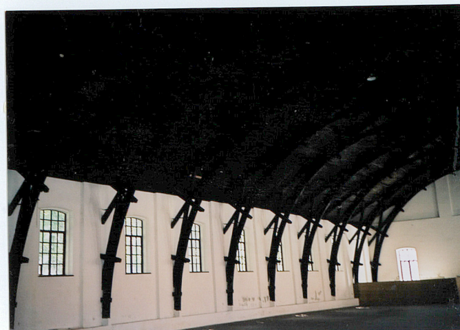
Wnętrze ujeżdżalni z odsoniętą konstrukcją dachową de L'Orme'a
