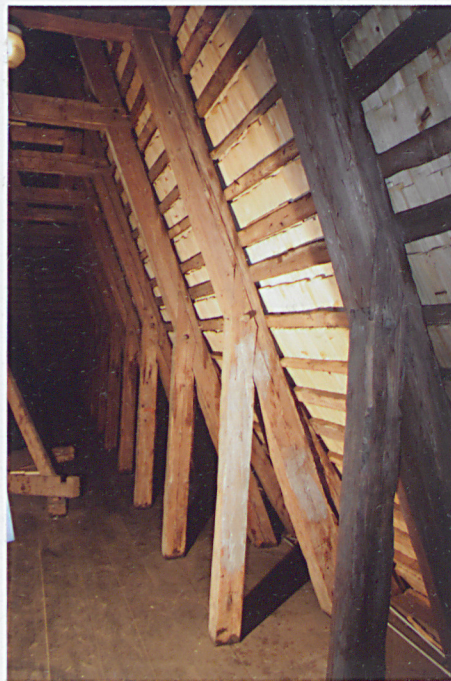
Fragment więźby dachowej; krokwie i miecze stopowe wiazara
