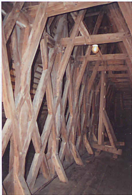
Rama storczykowa; widoczne umocnienia wzdłużne – zastrzały w formie krzyży św. Andrzeja; miecze stopowe storczyka, jętki, podwalina i rygiel odcinkowy
