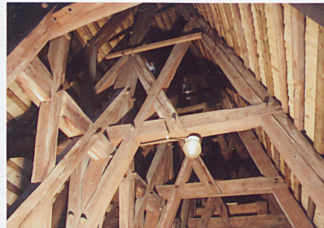
Górna część więźby; widoczne krokwie, jętki i zastrzały oraz fragment umocnień wzdłużnych
