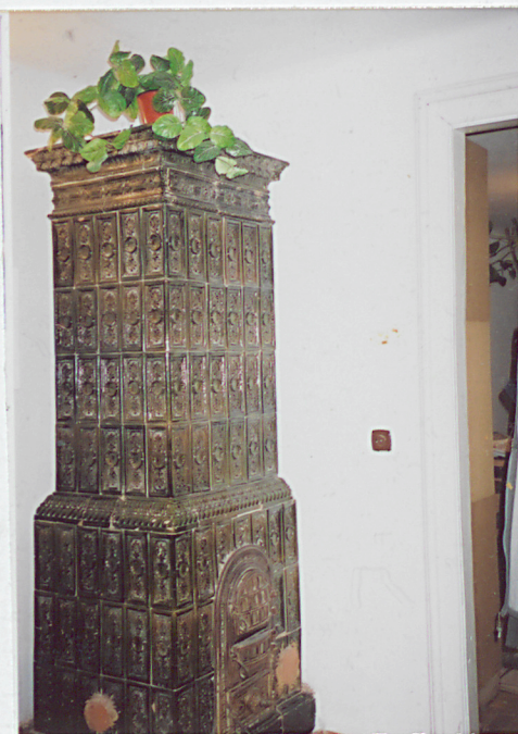
Piec w mansardzie oraz drzwiczki do paleniska
