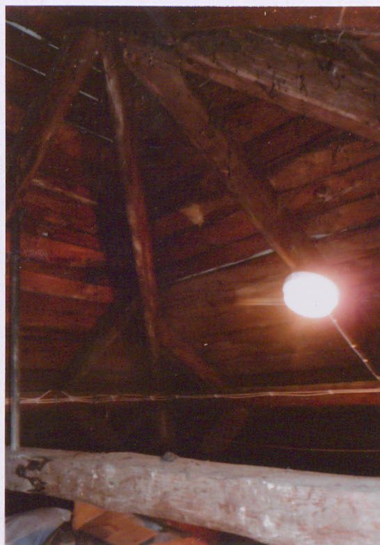
ELEMENTY WIEZBY DACHOWEJ I DESKOWANIE PEŁNE DACHU
