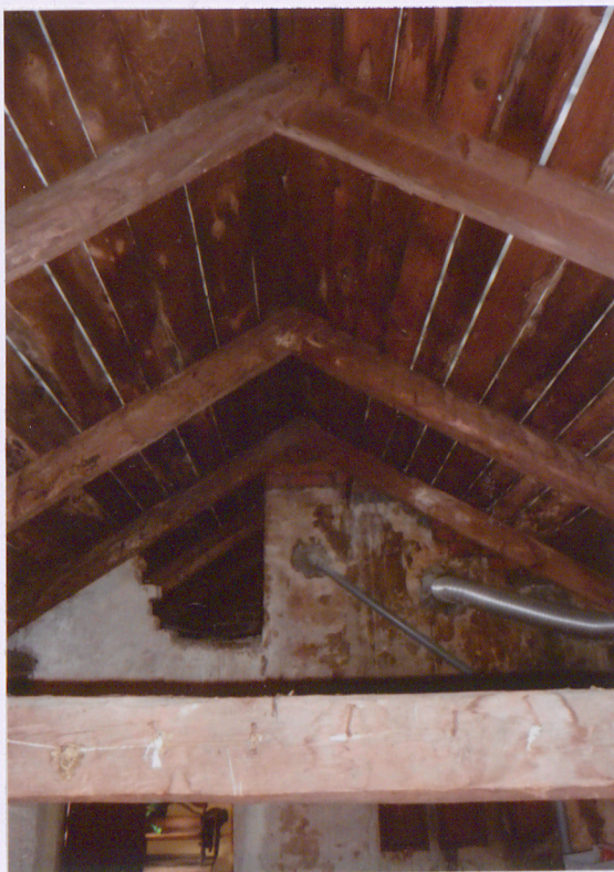
ELEMENTY WIEZBY DACHOWEJ I DESKOWANIE PEŁNE DACHU
