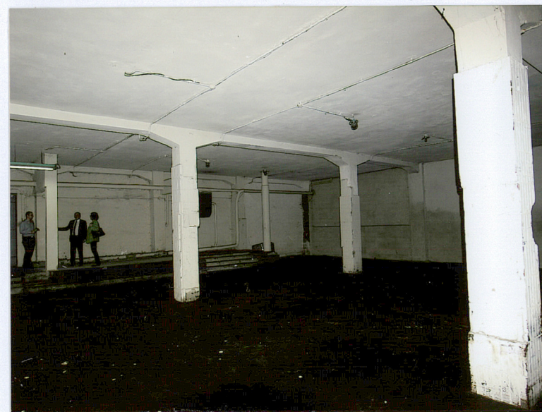
Wnętrze części piętrowej budynku. Dawna jadalnia dla uczniów na parterze. Widoczny jest oryginalny układ konstrukcyjny: żelbetowe słupy z częściowo zachowaną okładziną z płytek ceramicznych, żelbetowe rygle i strop. W głębi podest obok wejścia. Widok od pd.
