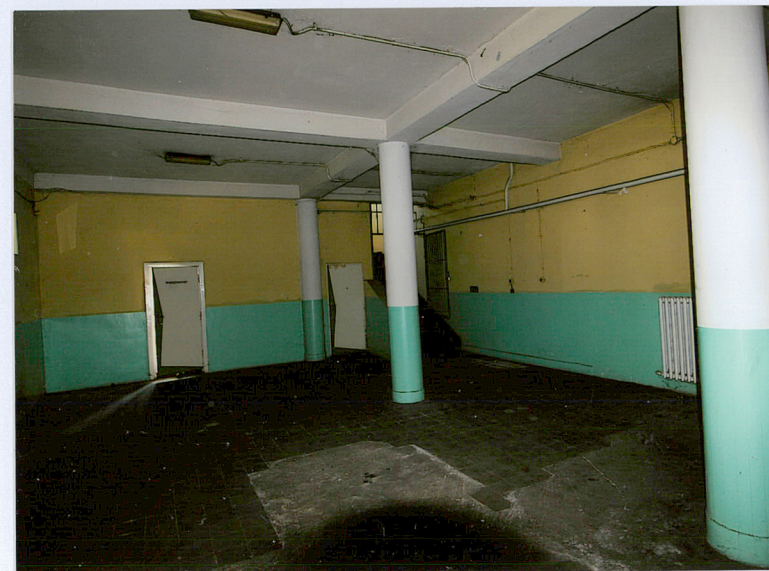
Wnętrze części piętrowej budynku. Część wschodnia hallu na parterze. Widoczne są elementy konstrukcyjne – żelbetowe słupy, rygle i strop. Widok od zach.
