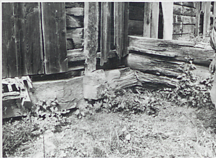
prycieś na styku ze wschodnią ścianą zakrystii
