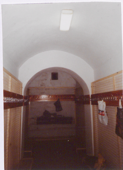
sklepienie odcinkowe w piwnicy
