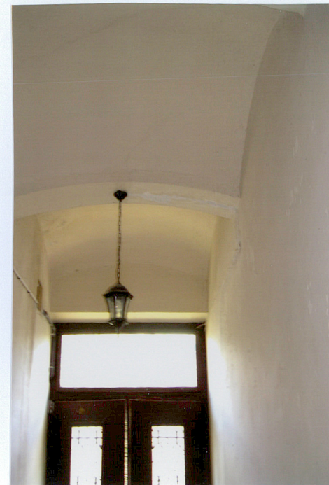
19. sklepienie odcinkowe w sieni
