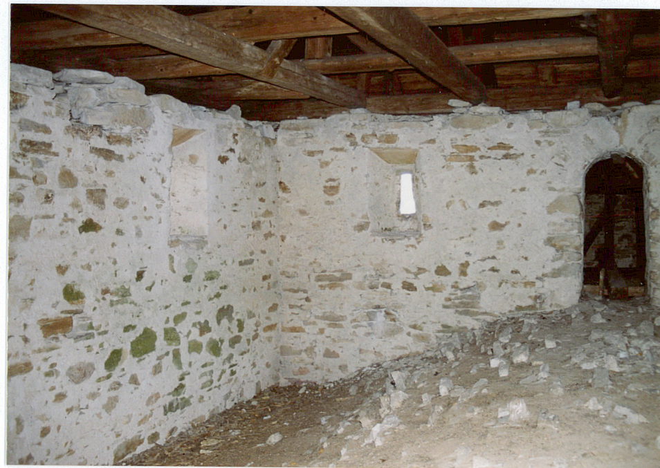
Poddasze nawy. Widoczne sklepienie i przejście na poddasze prezbiterium
