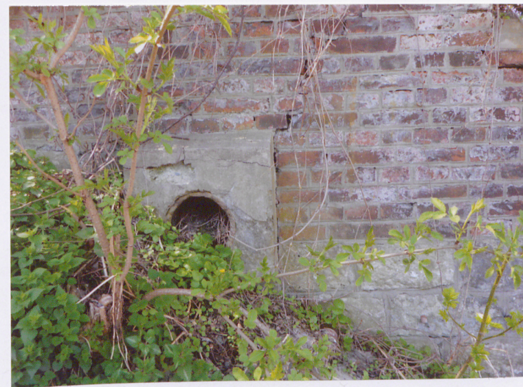
10. OTWÓR ODPEŁWOWY z KANAŁU na SKARPIE
