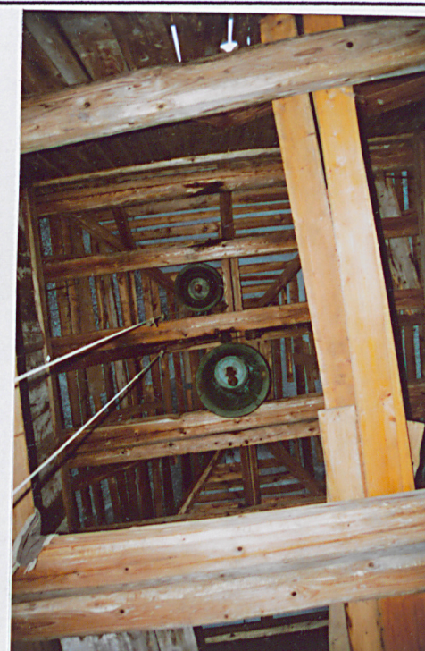
Konstrukcja więźby i zawieszenia dzwoń
