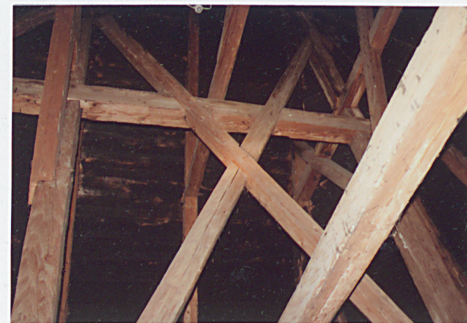
Krzyże z usztywnienia wzdłużnego nad prezbiterium
