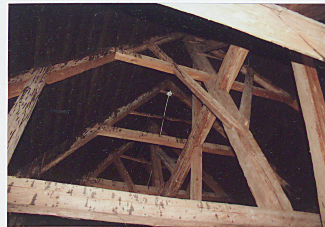
Górna część ramy storczykowej; widoczna górna i dolna jętka, zastrzały i rygiel sztywnienia wzdłużnego
