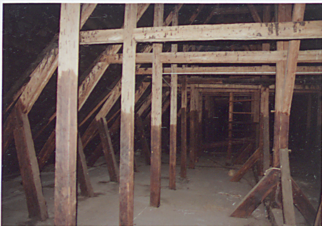
Widok ogólny wieżby dachowej nad nawą; rama storczykowa, dolne jętki, krokwie, zastrzały i miecze stopowe wiażara
