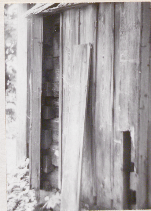
węgieł zrębu ścian prothesis
