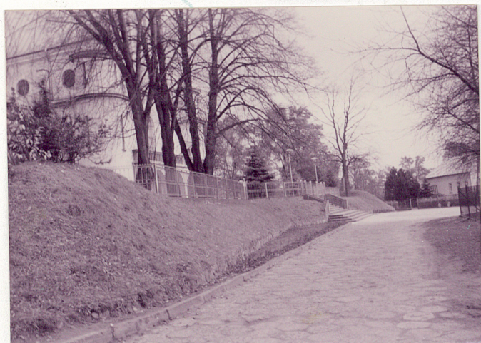
Zniszczona środkowa część ziemnych obwałowań przez wybudowanie schodów do nowego kościoła z lat 30-tych XX w.
