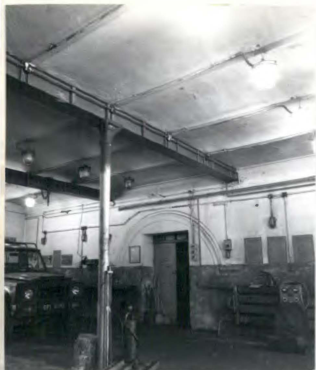
Fot.34. Wnętrze stajni (6) → żeliwna kolumna, podciąg, sklepienia odcinkowe.
