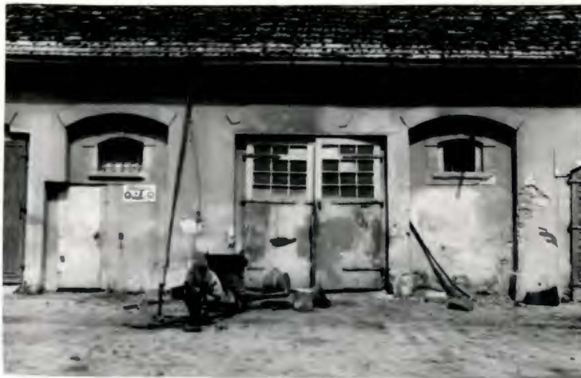
Fot.27. STAJNIA-WOZOWNIA /4/ → fragment elewacji południowej oryginalna artykulacja ściany → wysokimi ślepyimi arkadami, jedynie z małymi otworami okiennymi na osi w górnej części. Arkady i otwory okienne - sklepięne łukami odcinkowymi. Otwory drzwiowe przemurowane.
