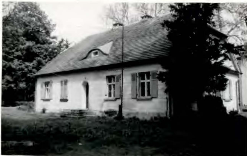
Fot.40. Elewacja dłuższa południowa - tylna w stosunku do pałacu, ale główna widoczna z drogi; pięcioosiowa, w środkowej osi półkoliście zamknięty otwór drzwiowy i okno powiekowe (wóle oko) w połaci dachowej.
