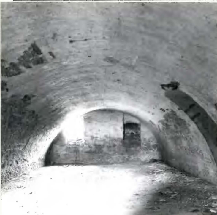
Fot.65. Wnętrze sklepionej kolebkowo piwnicy pod jednym sąsiekiem (zach.) stodoły /24/ → widok wzdłuż wnętrza, od strony północnej w kierunku południowym..
