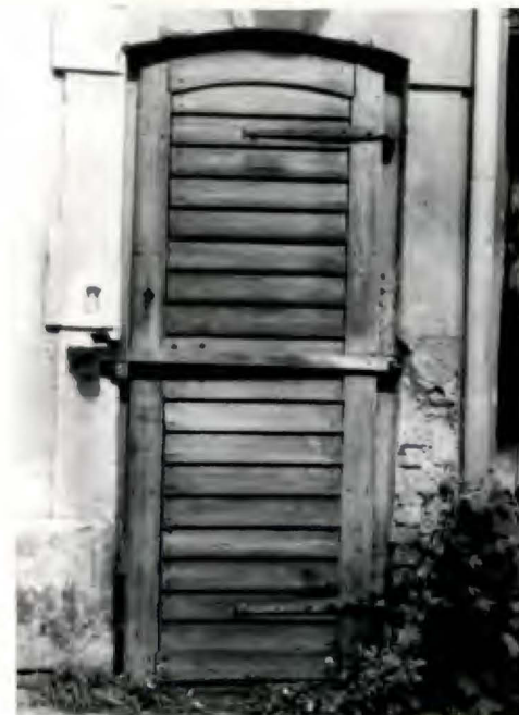
Fot.30. Drzwi do klatki schodowej prowadzącej do poddasza - skrajne od wschodu w elewacji południowej - opierane deskami w układ ramowy wewnątrz wypełniony deskami nabitymi poziomo.
