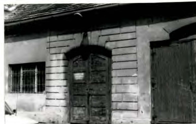
Fot.26. Zachodni fragment południowej elewacji dłuższej budynku STAJNI-WOZOWNI /4/ → oryginalne drzwi ramowo-płycinowe w oryginalnym boniowanym obramowaniu.
