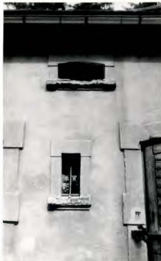
Fot.29. Fragment elewacji południowej zróżnicowane wykroje otworów okiennych - wszystkie z kształtowanymi w tynku obramowaniami o wyraźnie zaznaczonych nadprożach.
