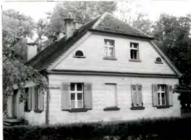
Fot.36. Fasada oficyny /2/ - pięcioosiowa z przesłem środkowym wysuniętym w pseudoryzalit, w którym środkowa część mieści wgłębny portyk z parą kolumn toskańskich, flankowanych parzystymi pilastrami; pseudo- ryzalit zwieńczony trójkątnym frontonem z odcinkowym otworem okiennym na osi tympono- nu. Parterowa bryła nakryta stromym dachem dwuspadowym z naczółkami.
