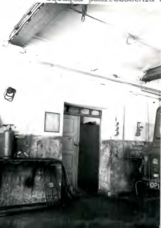
Fot.28. Oryginalny otwór drzwiowy do wnętrza stajni 11 → obramowanie z zaznaczonym łukiem, kluczem i uszankami.
