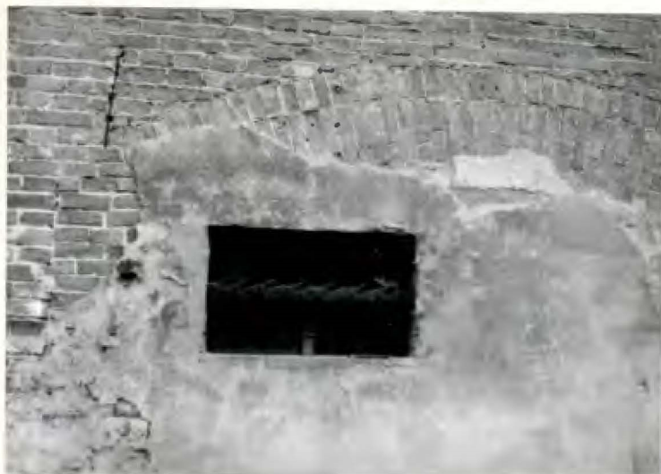
Fot.75. Okno w północnej elewacji spichlerza /22/ z kratą z zadziiorami, wymurowane wtórnie w miejscu dawnych szerokich drzwi.
