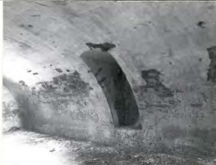
Fot.66. Wnętrze piwnicy pod skrajnym od zachodu przesłem stodoły /24/ → luneta w której pierwotnie były drzwi - przejście do spichlerza /22/.
