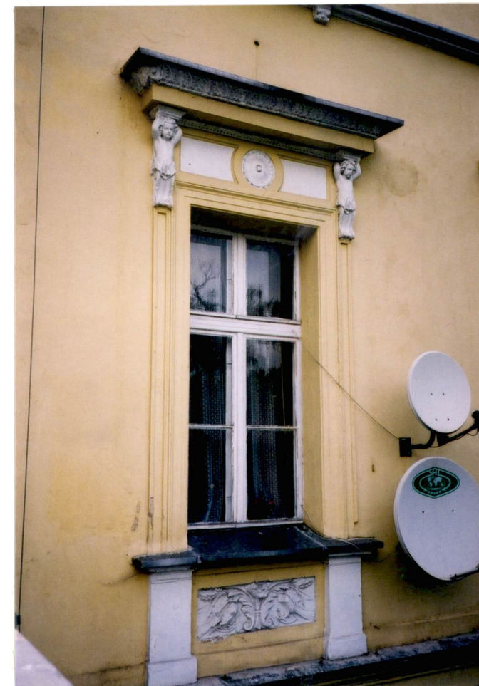
16. Obramowanie otworu okienne poszerzone lizenami i przedłużone w podokiennik
