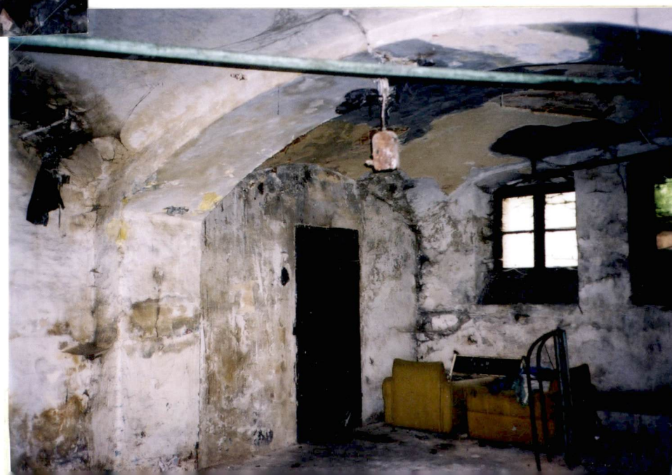
41. Sklepienia żaglaste w piwnicy.
