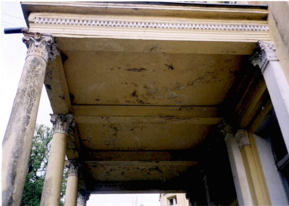
14. Porastanie glinami elewacji i zniszczenia spowodowane zasoleniami.
