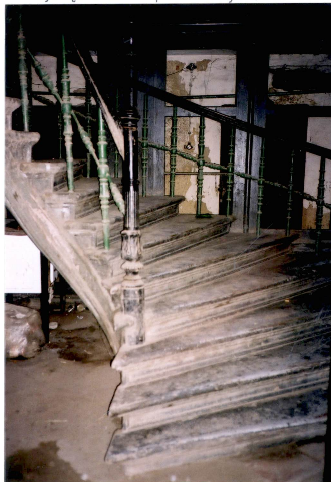
39. Początek schodów w piwnicy - skręt biegu i nałożenie stopni na schodkowe wycięcia belek policzkowych.
