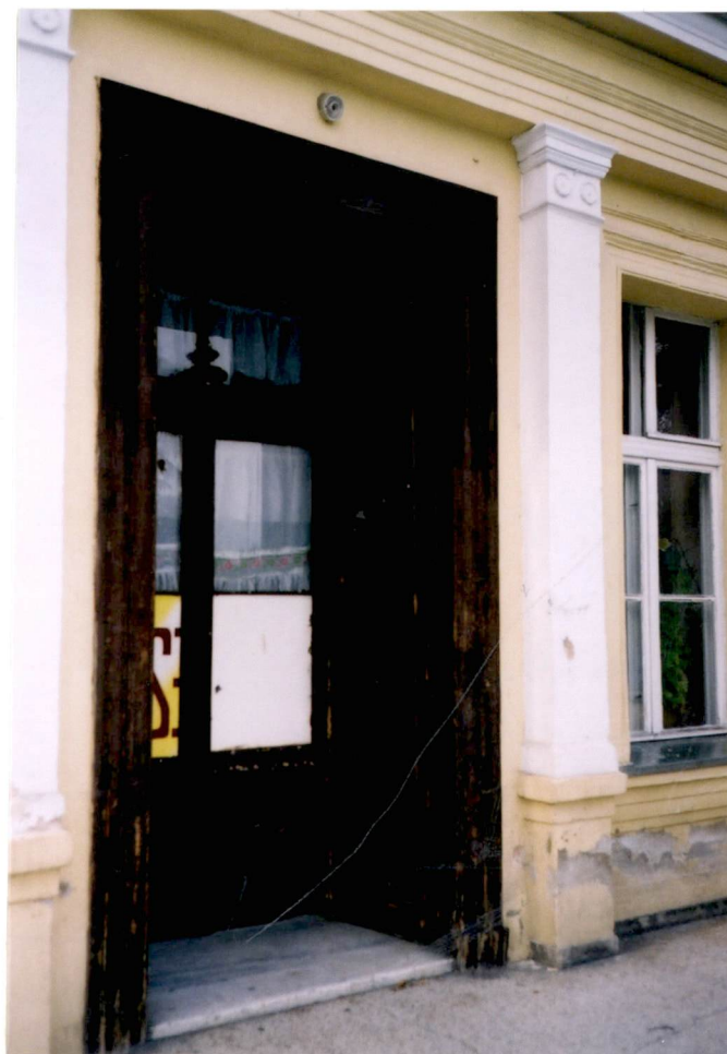
17. W obu zewnętrznych otworach drzwiowych marmurowe progi z jednego bloku kamienia.
