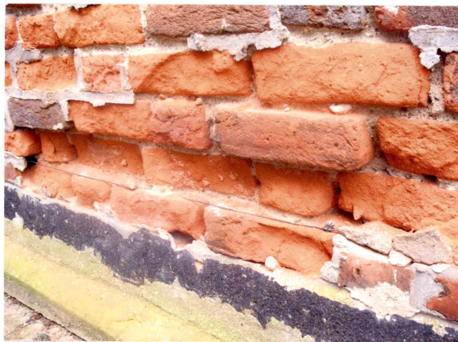
Ubytki w ceglanej powierzchni murów
