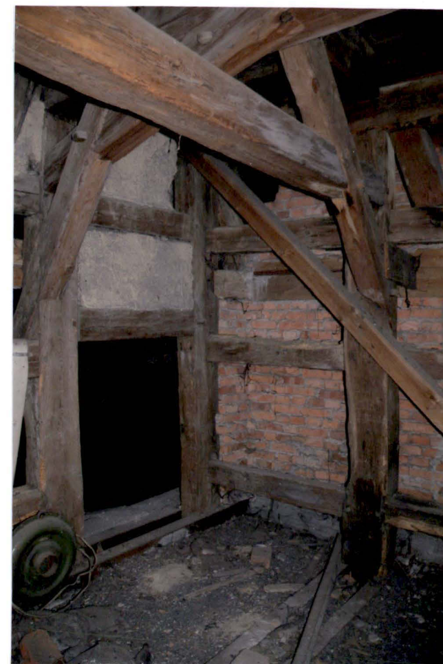
36. Wnętrze wieży, konstrukcja szkieletu II kond.
