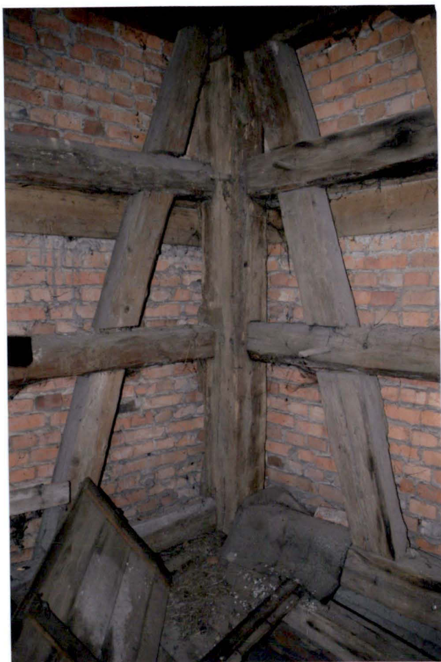
34. Wnętrze wieży, konstrukcja szkieletu II kond.
