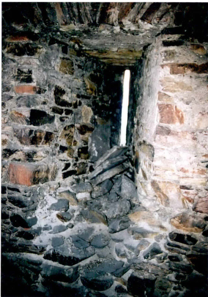
53. Glif otworu okna szczelinowego w pd. ścianie wieży pd.
