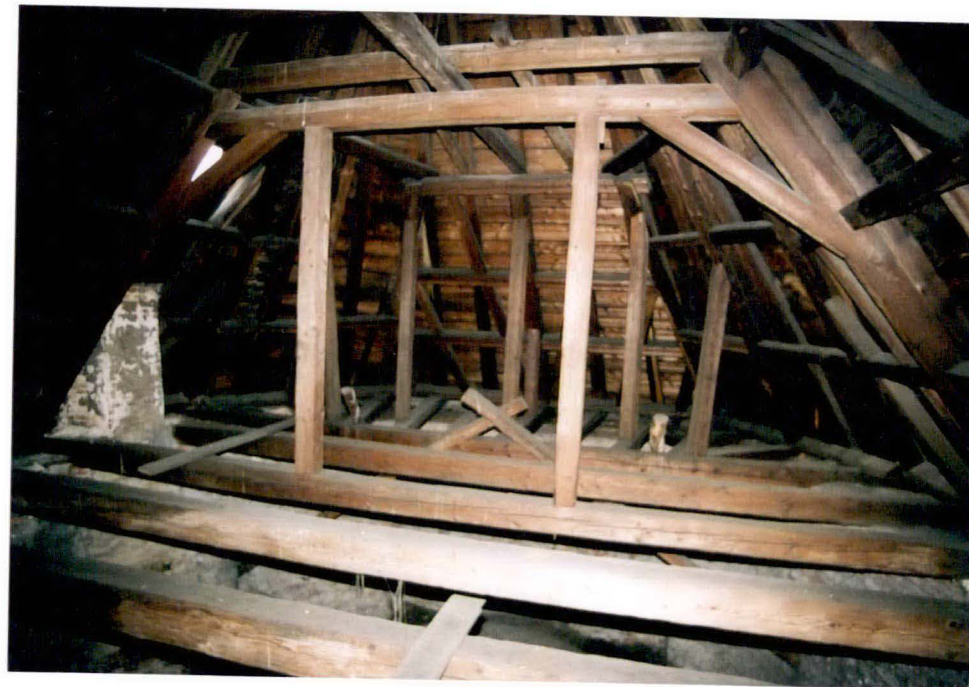
54. Konstrukcja więźby dachowej nad prezbiterium.
