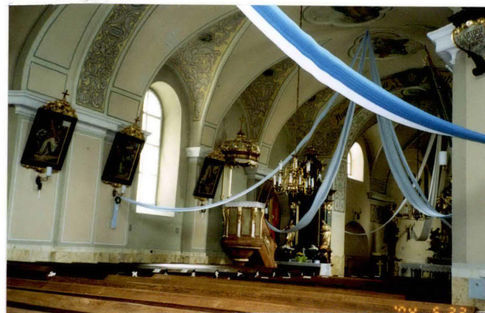
nawa główna – sklepienie kolebkowe z lunetami
